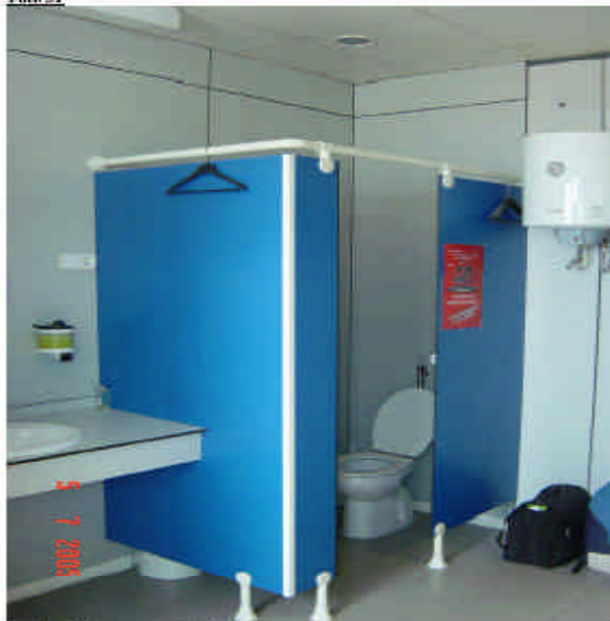
Lavabo de dones sense ventilació
