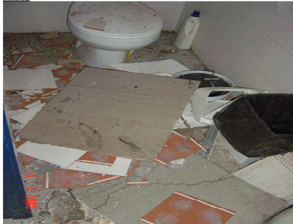
Estat del lavabo després de la caiguda del sostre i les rajoles de la paret
